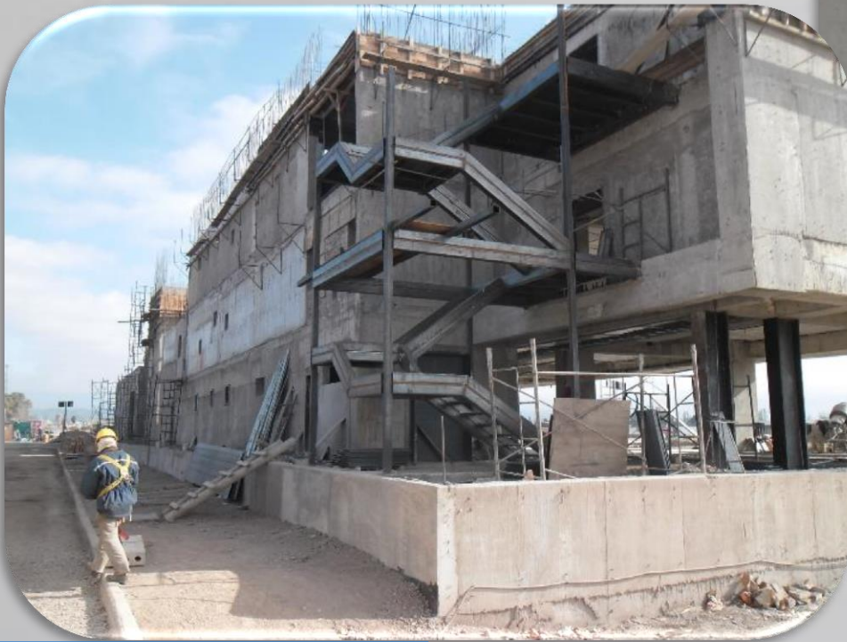
Vista exterior del edificio
